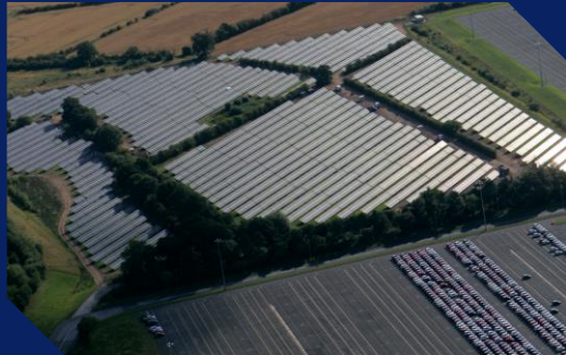
4.1 MWp ground mount 1MWp地上設置型集光パネル
